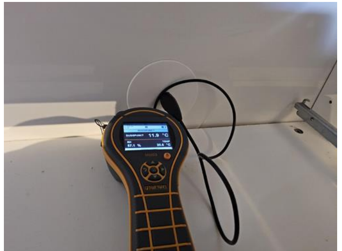
Våtrom - [Fuktmåling baderom]
