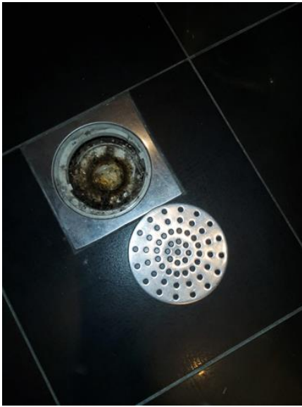
Membran, tettesjikt og overgang til sluk. - [Sluk Vaskerom, ved dør.]
