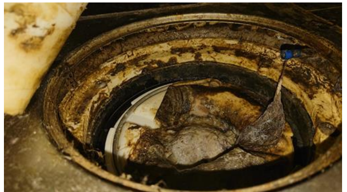
Membran, tettesjikt og overgang til sluk. - [Sluk Baderom, under dusjkabinett. ]
