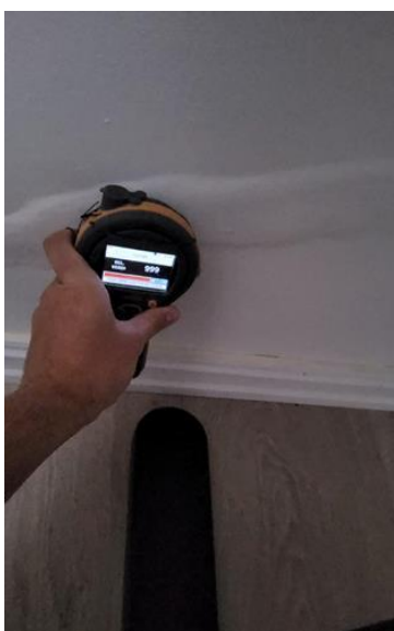
Konstruksjoner (tilfarergulv, himling og vegger). - [Fuktsøk kjellervegg]
