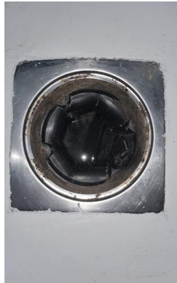
Avløpsrør (ink. sluk) - [Sluk på vaskerom]
