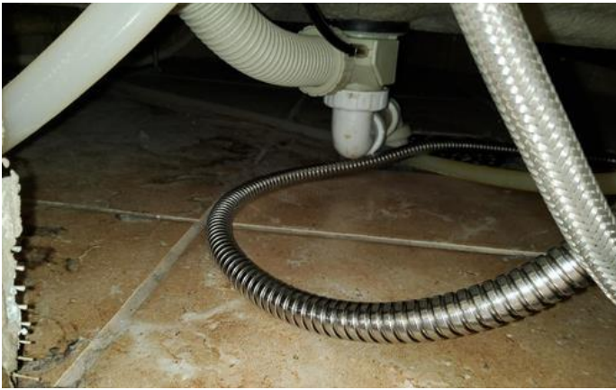
Membran, tettesjikt og overgang til sluk. - [Sluk bad 1]
