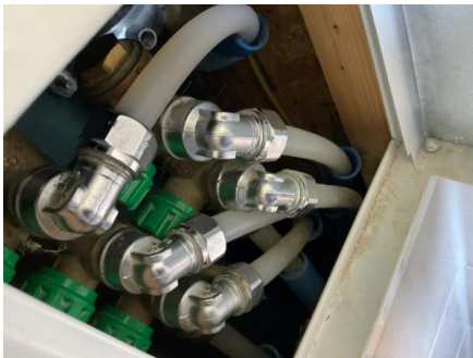
Det mangler tettemuffer på varerør
