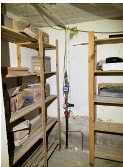
Det mangler tettemuffer på varerør
