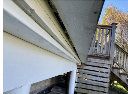
Lite lufting på panel for tilbygget
