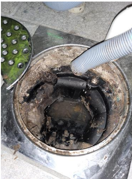
Membran, tettesjikt og overgang til sluk. - [Sluk bad 1.etasje ]
