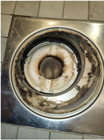
Våtrom - [Sluk bad ]
