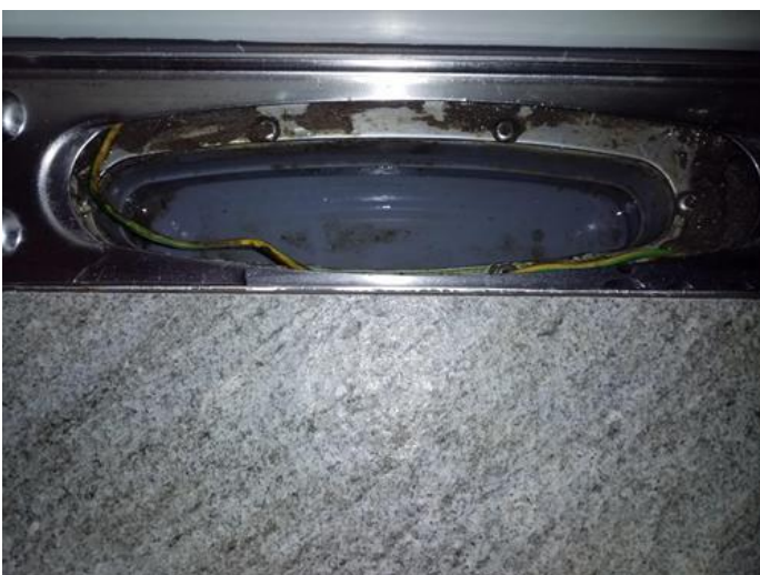
Membran, tettesjikt og overgang til sluk. - [Sluk i dusjsone. Bad 1.etasje.]
