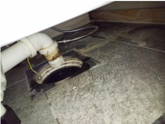
Membran, tettesjikt og overgang til sluk. - [Sluk under badekar i underetasje.]
