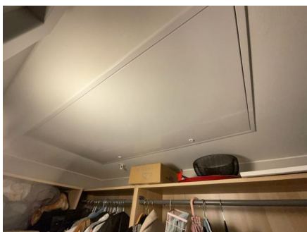
ventilasjonsaggregat i himling i boden
