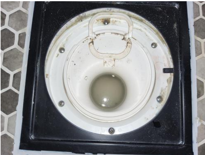
Membran, tettesjikt og overgang til sluk. - [Sluk på baderom ]
