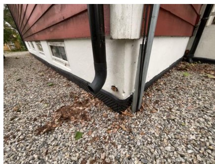
Synlig grunnmurspapp med tettelist.
