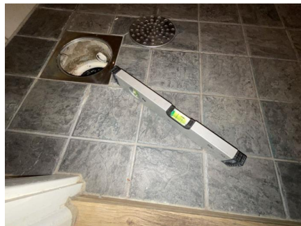
Fallforhold målt i retning sluk.
