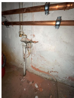
Frakoblet, original hovedvannledning og stoppekran.
