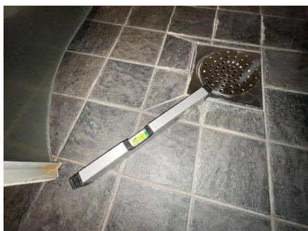
Fallforhold målt i retning sluk.
