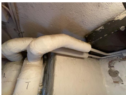
Isolerte radiatorrør.
