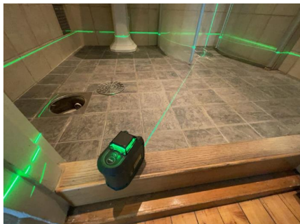
Fallforhold målt i retning sluk.
