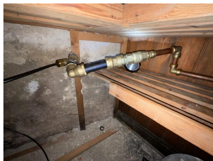
Nyere hovedvannledning med varmekabel.
