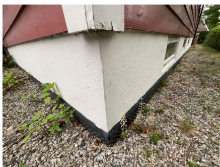
Pusset og malt grunnmur.
