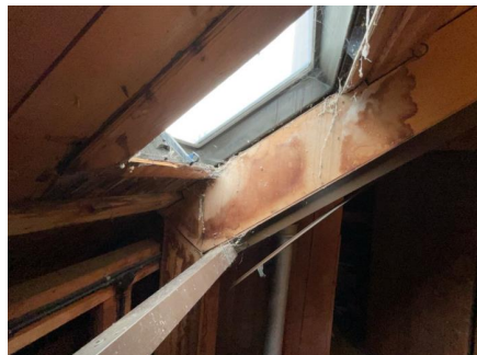
Råte. Fuktskjolder.
