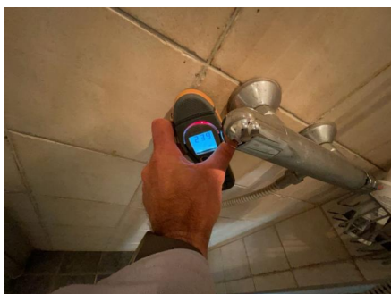
Fuktsøk med Protimeter fuktapparat.
