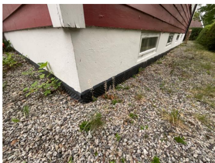
Synlig grunnmurspapp med tettelist.
