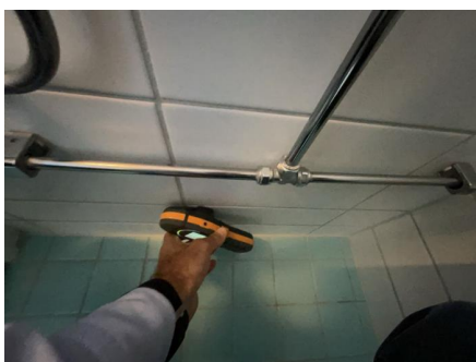
Fuktsøk med Protimeter fuktapparat.
