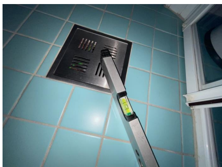
Fallforhold målt i retning sluk.
