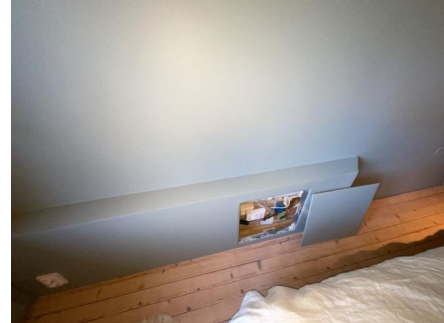
Inspeksjonsluke i vegg på soverom.
