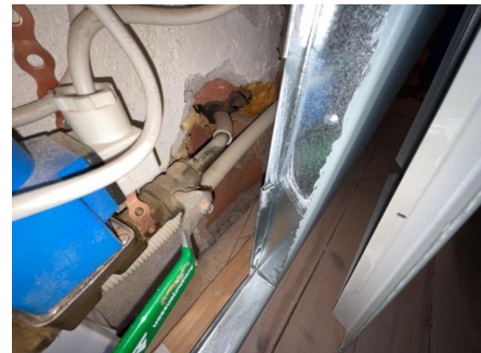
Originalt kobberør innerst til høyre.
