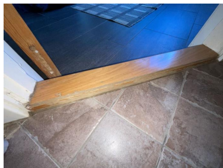
Overgang ved dørterskel.
