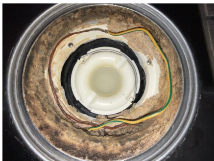
Sluk med klemring. Synlig dukmembran.
