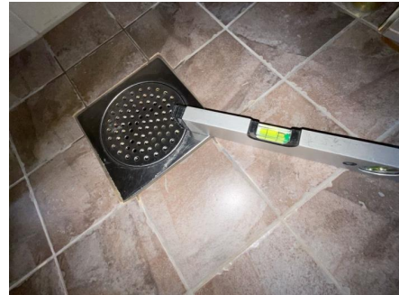
Fallforhold målt i retning sluk.
