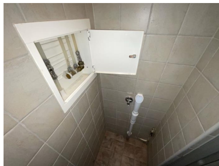
Fordelerskap. Drensspalte. Gammelt rør til høyre.
