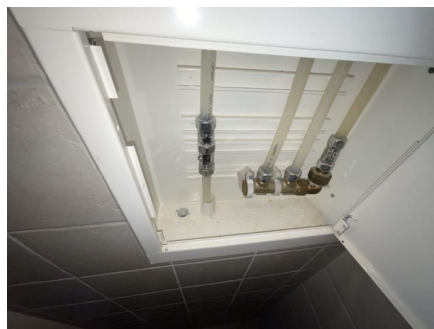
Fordelerskap. Drensspalte. Gammelt rør til høyre.
