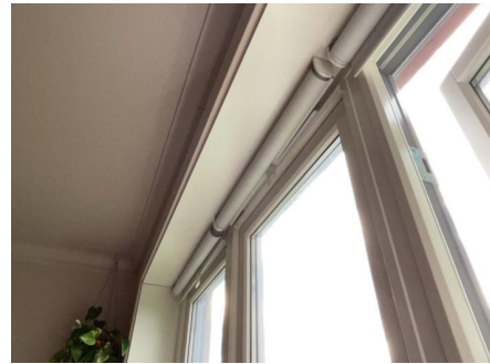
Luftespalte over vindu.
