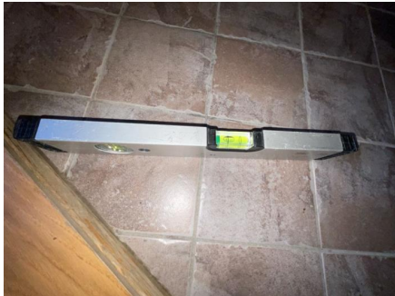
Fallforhold målt i retning sluk.
