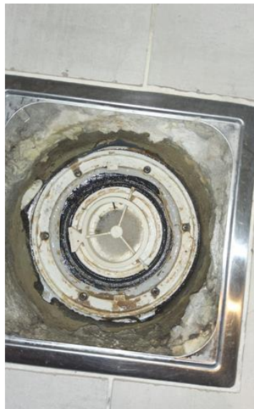
Avløpsrør (ink. sluk) - [Hovedsluk på bad]
