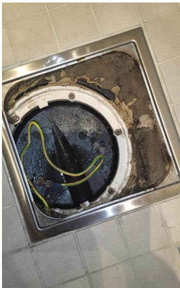
Avløpsrør (ink. sluk) - [Hjelpesluk på bad]
