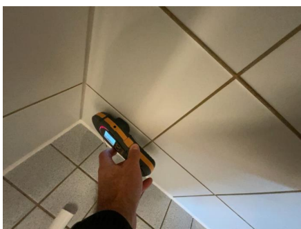
Fuktsøk med Protimeter fuktapparat.
