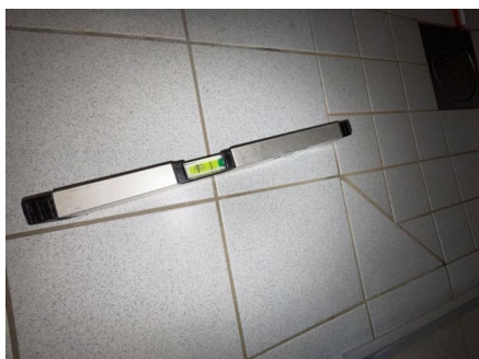
Fallforhold målt i retning sluk.
