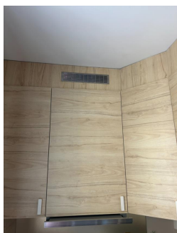
Kullfiltervifte montert etter takstbefaring.
