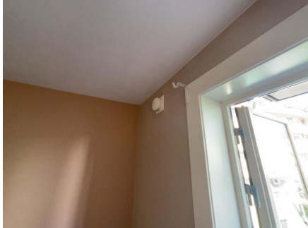
Lufteluke i yttervegg i stue.
