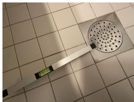
Fallforhold målt i retning sluk.
