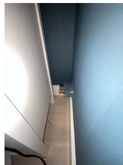
Gamle vannrør og avløpsrør er blendet ved vegg på soverommet.
