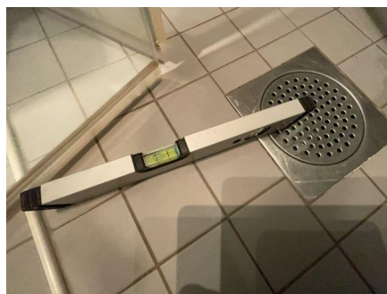
Fallforhold målt i retning sluk.
