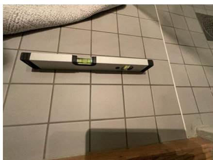
Fallforhold målt i retning sluk.
