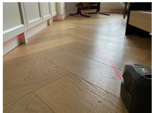
Nivellering stue, små avvik
