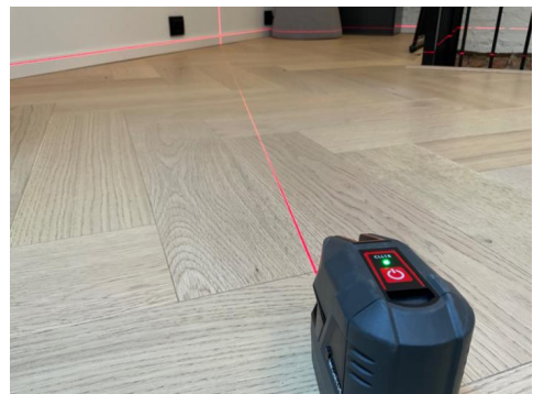
Nivellering loftstue, ingen avvik registrert
