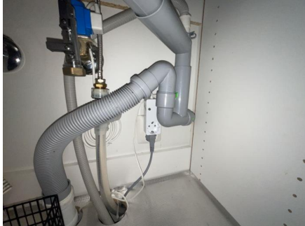
Lekkasjesensor i underskap på kjøkken.
