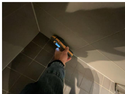
Fuktsøk med Protimeter fuktapparat.
