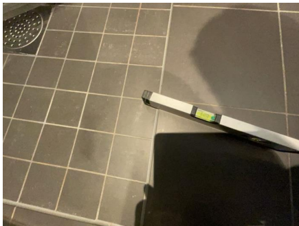
Fallforhold målt i retning sluk.
