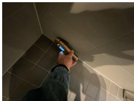
Fuktsøk med Protimeter fuktapparat.
