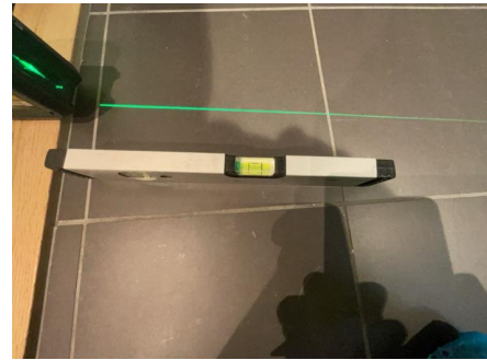
Fallforhold målt i retning sluk.
