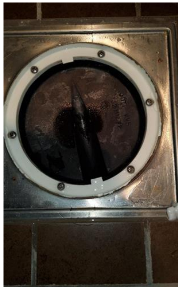
Membran, tettesjikt og overgang til sluk. - [Hjelpesluk bad]
