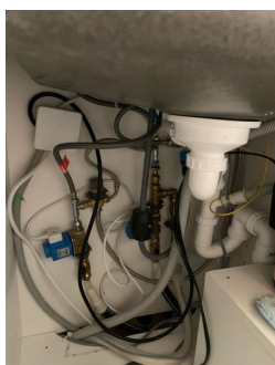
Nye rør i skap under vask på kjøkkenet.
