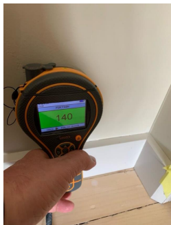
Fuktmåling baderom fra tilstøtende rom.
