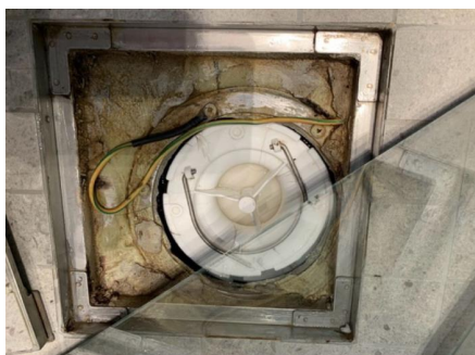
Baderomssluk plassert i dusjsonen.
