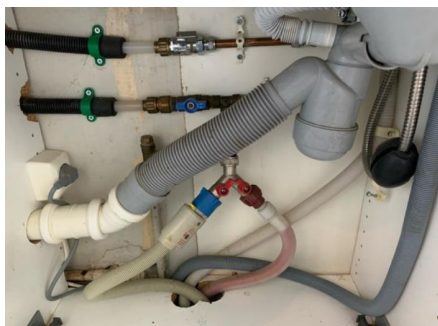
Avløpsrør i underskap vask på kjøkkenet.
