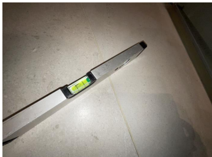
Fallforhold målt i retning sluk.
