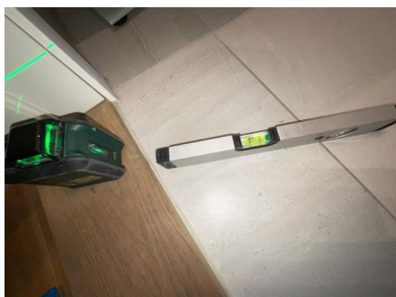
Fallforhold målt i retning sluk.
