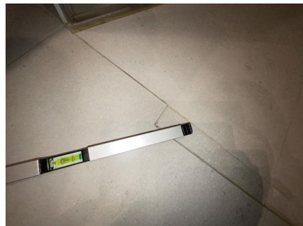
Fallforhold målt i retning sluk.
