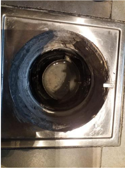
Membran, tettesjikt og overgang til sluk. - [Sluk i badrom 1.]
