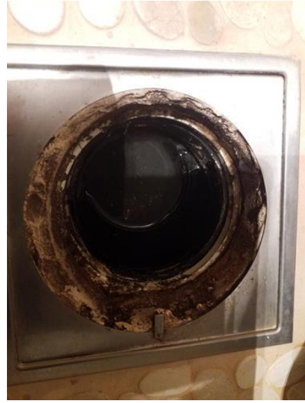
Membran, tettesjikt og overgang til sluk. - [Sluk i badrom 2.]
