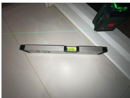
Fallforhold målt i retning sluk.
