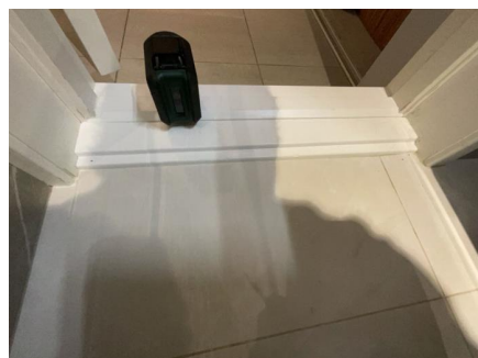
Overgang ved dørterskel.
