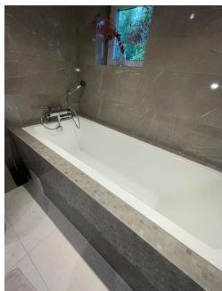
Innmurt badekar med flislagt front.
