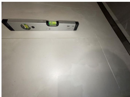
Fallforhold målt i retning sluk.
