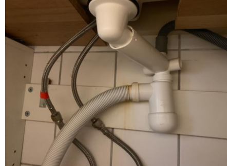
Rørøpplaget i bad.
