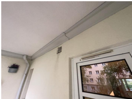
Ventil i yttervegg på balkong.
