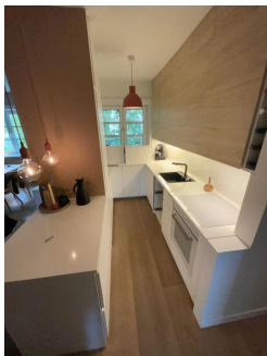
Kjøkken. Skuffer er fjernet mht. inspeksjon under takstbefaringen.
