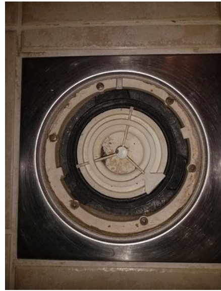
Membran, tettesjikt og overgang til sluk. - [Sluk i dusjsone i bad 1.]
