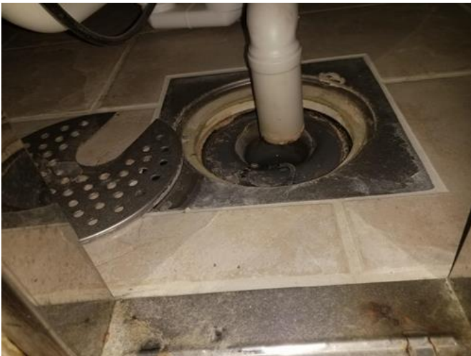
Membran, tettesjikt og overgang til sluk. - [Sluk under badekar i bad 1.]
