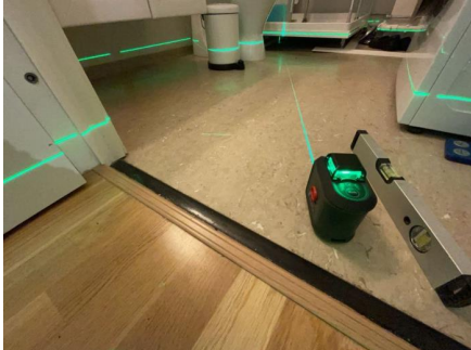
Fallforhold målt i retning sluk.
