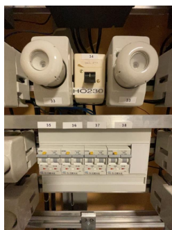
Skrue- og automatsikringer i felles el.skap i fellesgangen.
