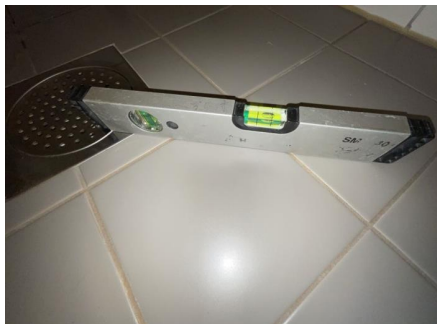
Fallforhold målt i retning sluk.
