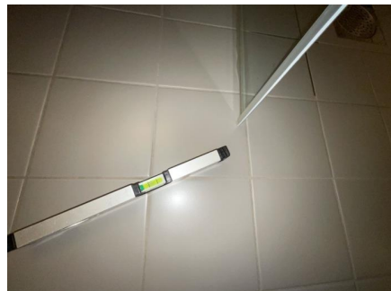
Fallforhold målt i retning sluk.
