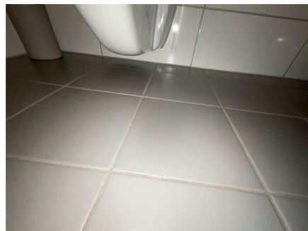
Ikke synlig drensspalte under toalettsisterne.
