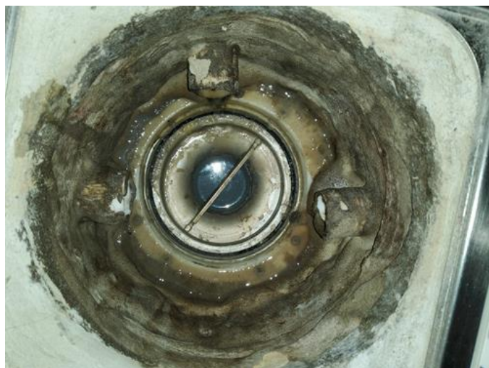
Membran, tettesjikt og overgang til sluk. - [Sluk]
