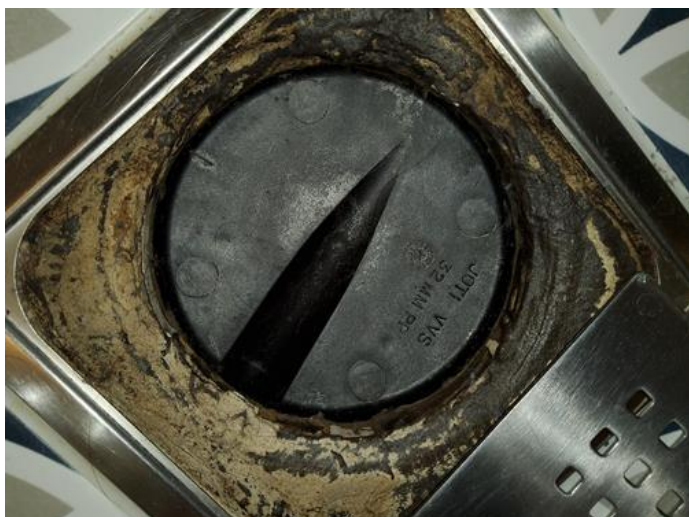
Membran, tettesjikt og overgang til sluk. - [Hjelpesluk]
