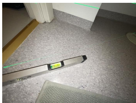
Fallforhold målt i retning sluk.
