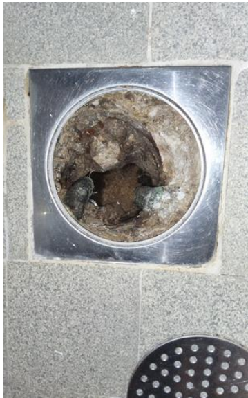
Avløpsrør (ink. sluk) - [Sluk på bad]
