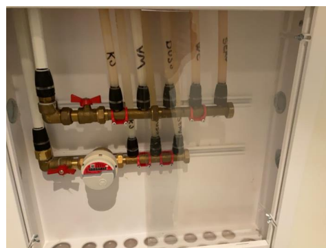
Fordelerskap i gang felles for utleiedel. Merk. Skapdør med bøy. Må rettes ut.
