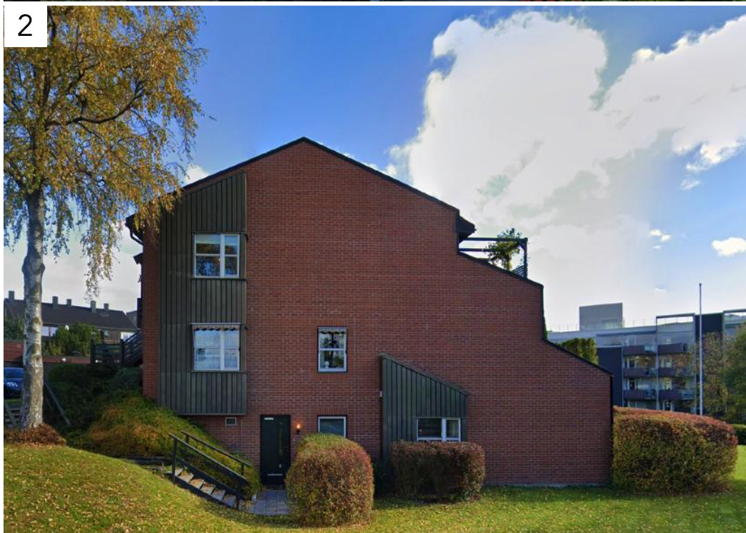
1. Svartmalt trepanel 2. Rød tegl. 3. Balkong i rustfritt stål og betong.
