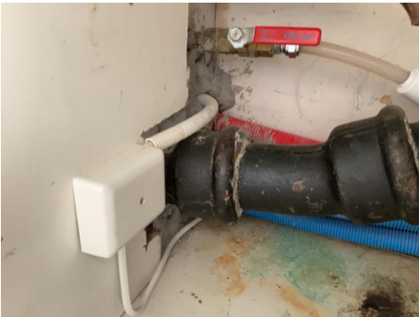
Avløpsrør i støpejern.
