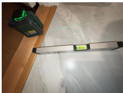
Fallforhold målt i retning sluk.
