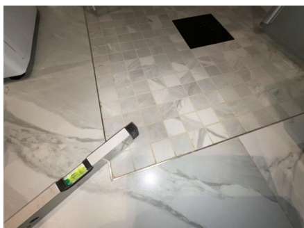
Fallforhold målt i retning sluk.
