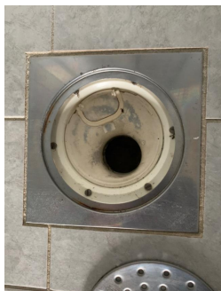
Baderomssluk plassert i dusjsonen.
