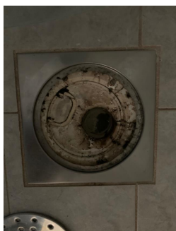
Baderomssluk plassert i dusjsonen
