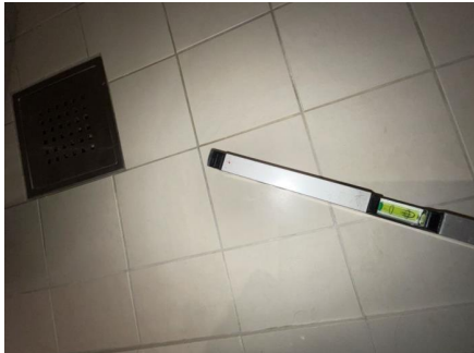
Fallforhold målt i retning sluk.
