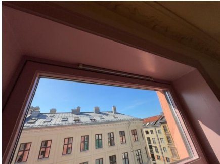
Luftespalte over vindu.
