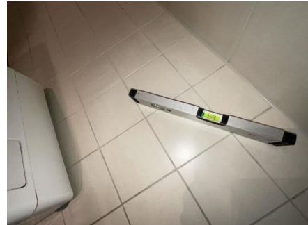
Fallforhold målt i retning sluk.
