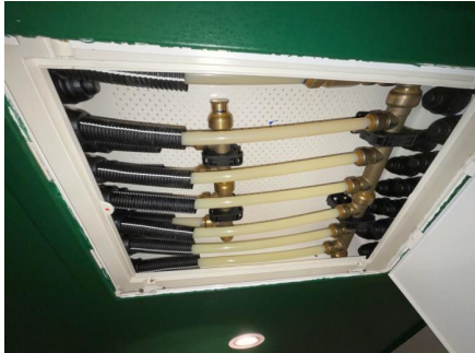
Fordelerskap i himling på badetrom.
