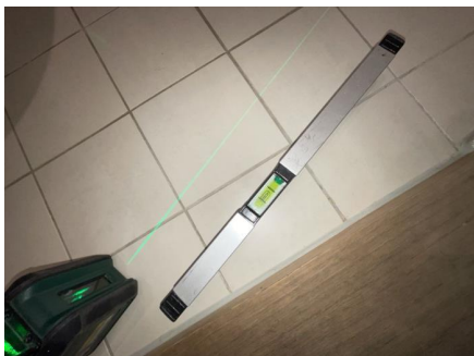
Fallforhold målt i retning sluk.
