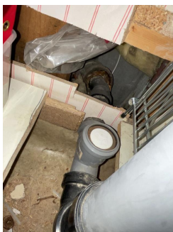
Både nytt og originalt avløpsrør.
