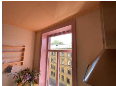
Luftespalte over vindu.
