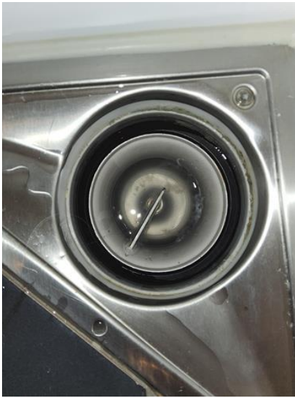
Våtrom - [Sluk bad]
