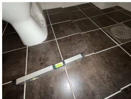
Fallforhold målt i retning sluk.
