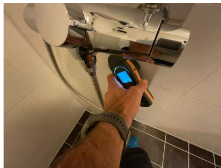
Fuktsøk med Protimeter fuktapparat.
