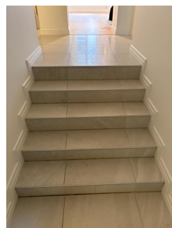
Innvendig trapp er en flislagt betongtrapp
