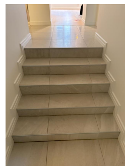
Innvendig trapp er en flislagt betongtrapp
