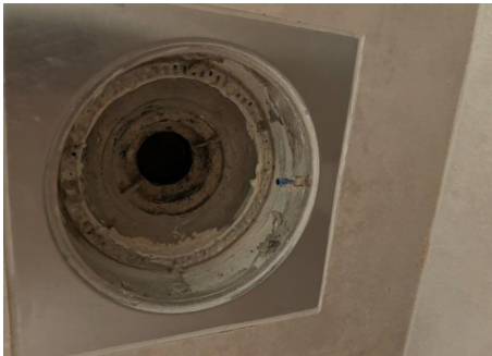
Baderomssluk plassert under servantskap.
