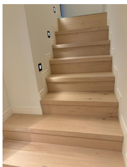
Kjellertrapp er en betongtrapp kledd med tre.
