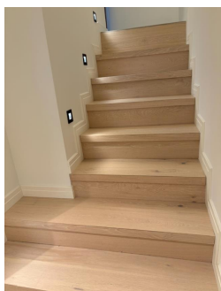
Kjellertrapp er en betongtrapp kledd med tre.
