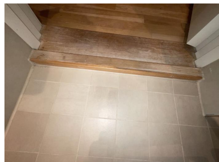
Overgang ved dørterskel.
