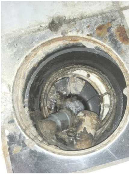
Våtrom - [Sluk bad ]
