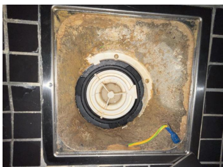
Synlig dukmembran under klemring i sluk.
