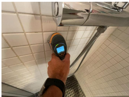
Fuktsøk med Protimeter fuktapparat.
