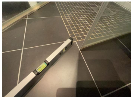
Fallforhold målt i retning sluk.
