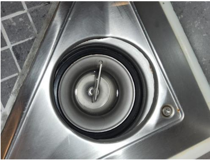
Membran, tettesjikt og overgang til sluk. - [Sluk bad ]
