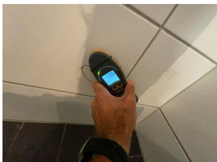
Fuktsøk med Protimeter fuktapparat.
