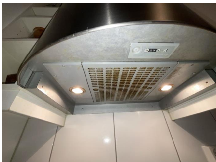
Avtrekkshette med spjeldløsning.
