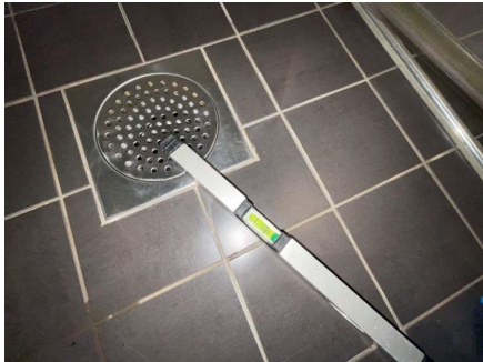
Fallforhold målt i retning sluk.
