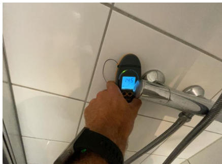
Fuktsøk med Protimeter fuktapparat.
