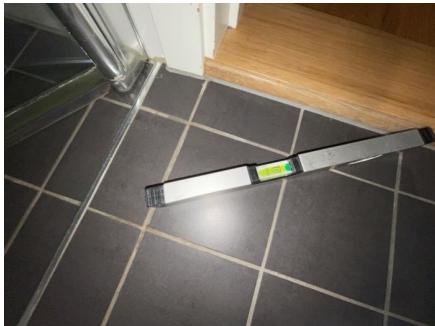
Fallforhold målt i retning sluk.
