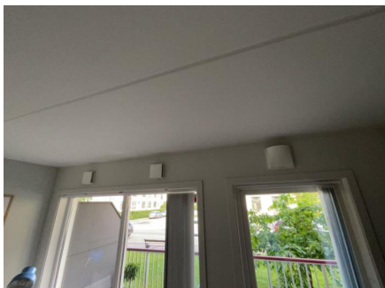
Lufteluker i yttervegg.
