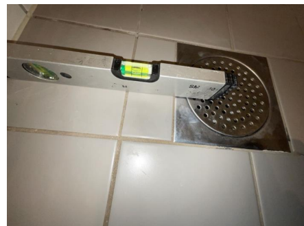
Fallforhold målt i retning sluk.
