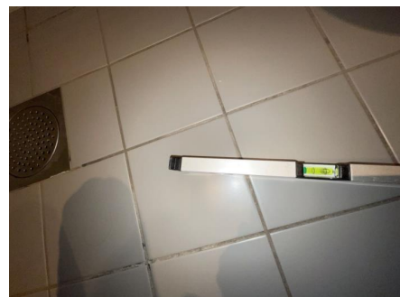
Fallforhold målt i retning sluk.
