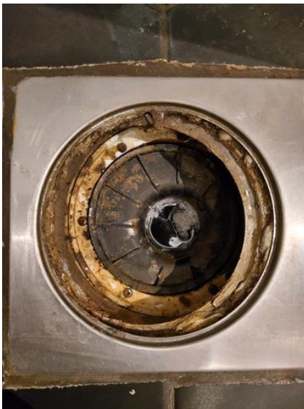
Membran, tettesjikt og overgang til sluk. - [Sluk]
